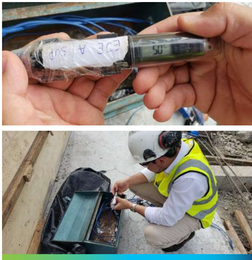
Figura 5. Verificación de termocuplas en obra
