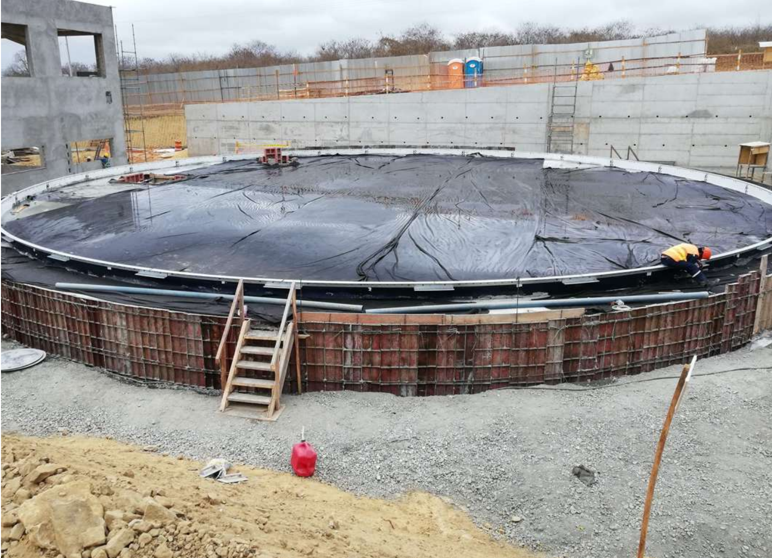
Figura 2. Concreto masivo en San Juan – Gral Villamil Playas
