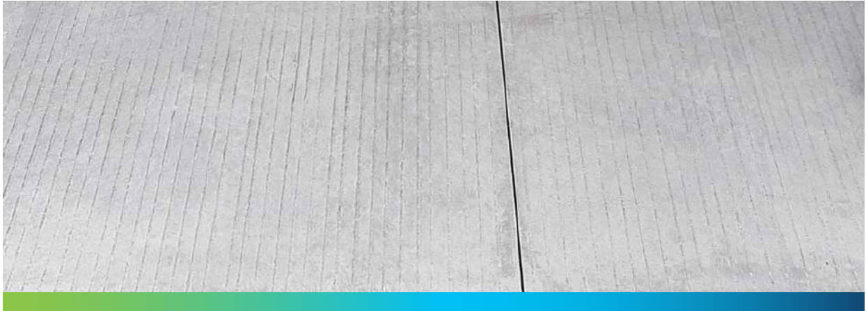
Figura 1. Pavimento RCC texturizado con peine metálico.
