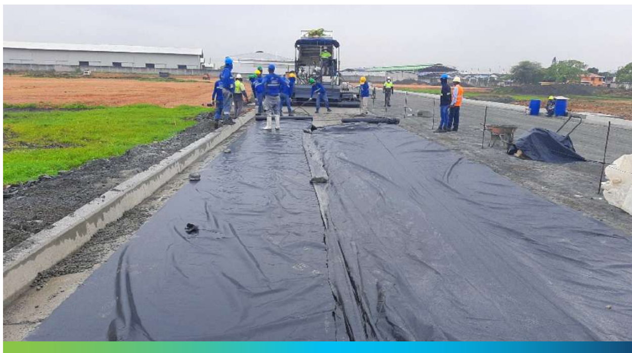
Figura 7. Curado con plástico y agua por al menos 7 días.
