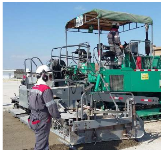
Figura 2. Pavimentadora con regla de alto poder de vibración.
