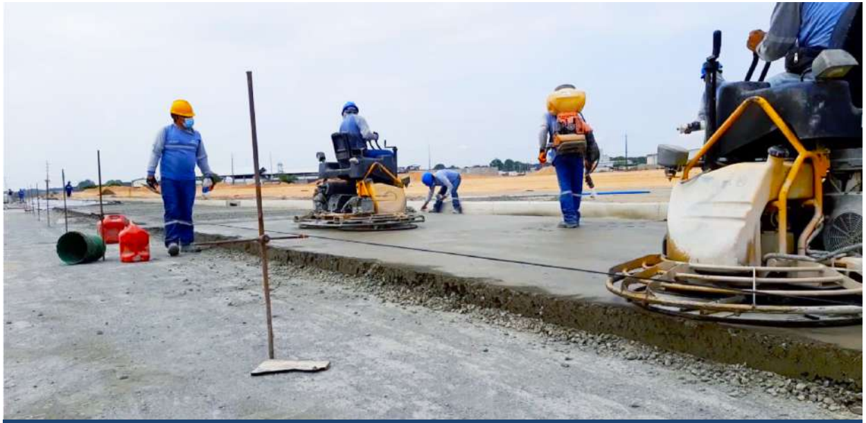
Figura 4. Alisadores mecánicos permiten tener más opciones de acabado en pavimento RCC.
