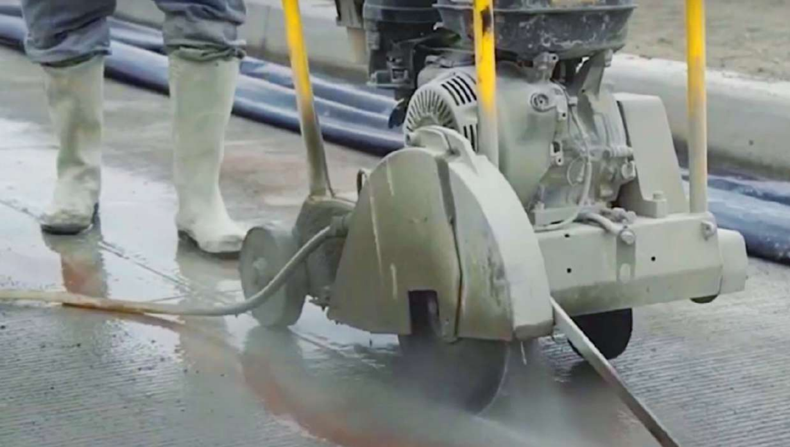
Figura 6. Corte de juntas a la mitad del carril del pavimento RCC.
