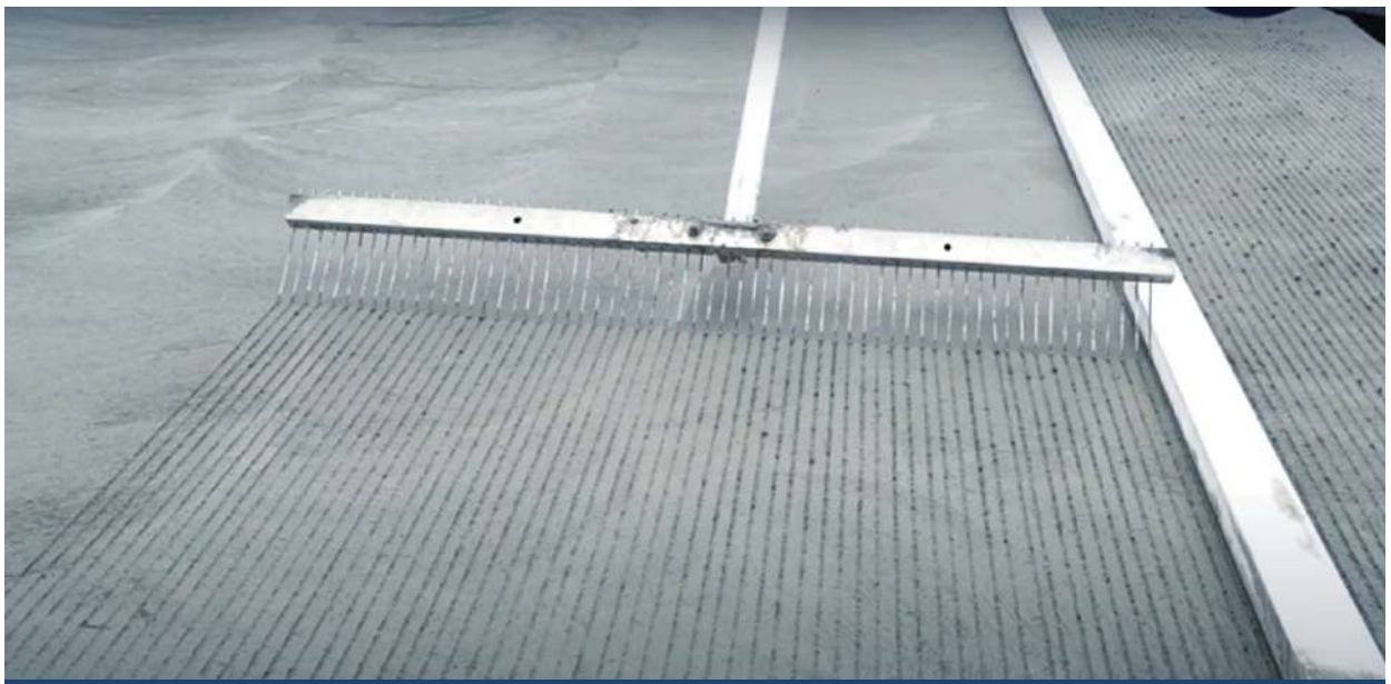
Figura 5. Texturizado con peine metálico, sobre la superficie alisada del concreto RCC.
