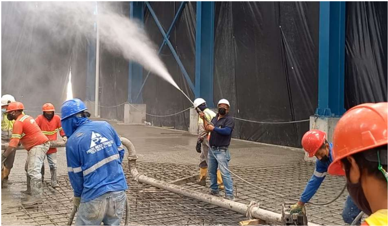
Foto 6. Ambiente cerrado con niebla de agua para crear las condiciones ideales de humedad que requiere el hormigón dentro de su curado inicial.
