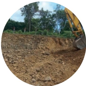
MATERIAL DE RELLENO
