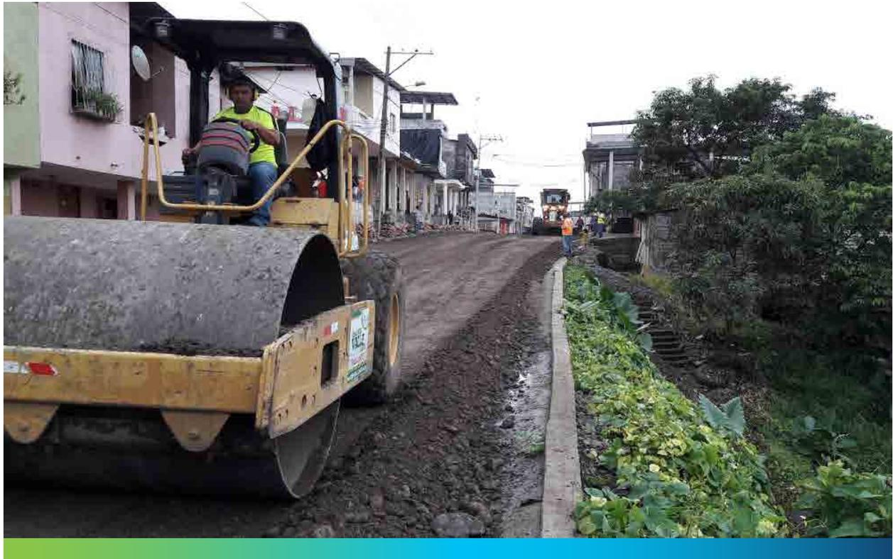
**Foto 4. La estabilización con cemento requiere que la mezcla se mantenga manejable para lograr su completa compactación desalojando todos los espacios vacíos. Esto se facilita trabajando con cemento Tipo MH.**
