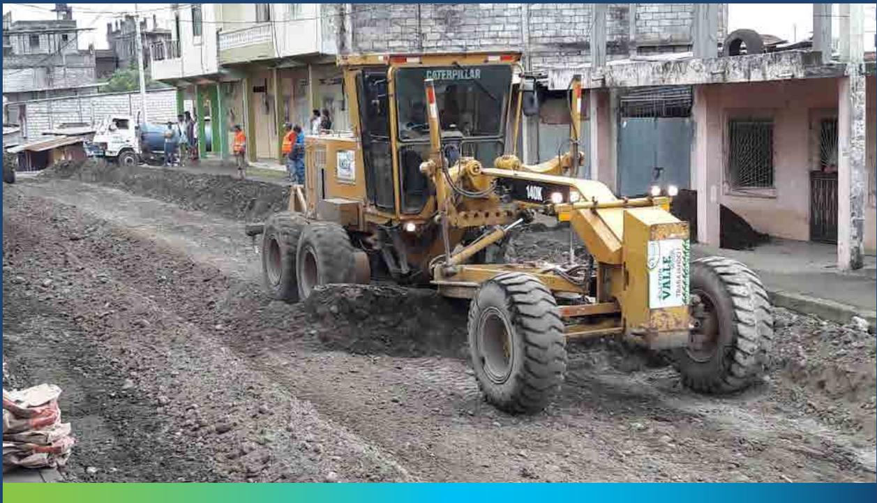
**Foto 3.** El Cemento Tipo MH proporciona el tiempo suficiente para uniformizar y extender la mezcla manteniendo la trabajabilidad. Los cementos normales producen un rápido endurecimiento que puede provocar sobreesfuerzos a la motoniveladora con posibles roturas de mangueras hidráulicas.
