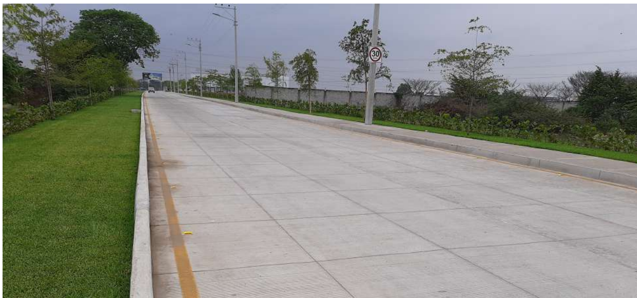
Figura 1. Samborondón. Vía Municipal TCP® en el ingreso a Almax 3. El aspecto de un pavimento TCP® es similar al del pavimento tradicional.
