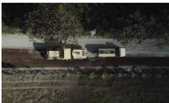
El tren de estabilización, una vez en marcha, permite rendimientos acelerados en la construcción de las vías.
