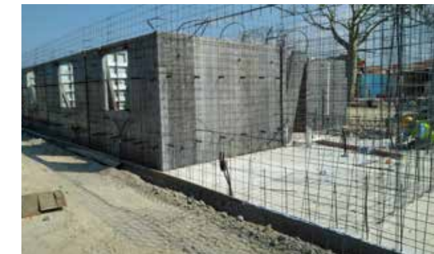
Obra en Jaramijó, Manta
